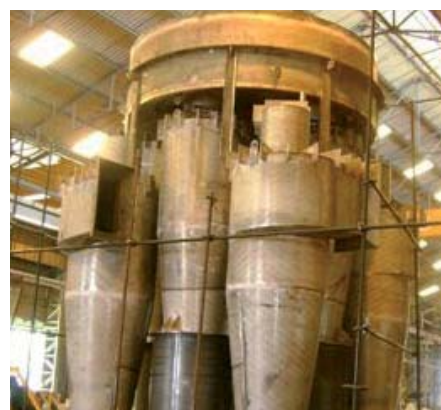
Premontaje de equipos en planta
