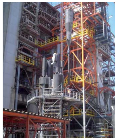
Premontaje de equipos en obra
